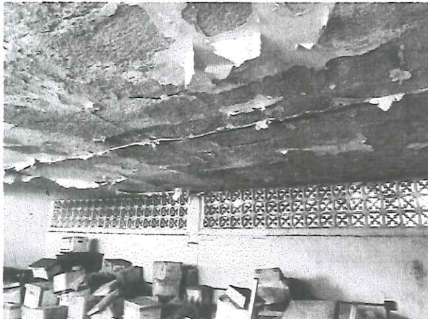
Imagen losa de entrepiso
