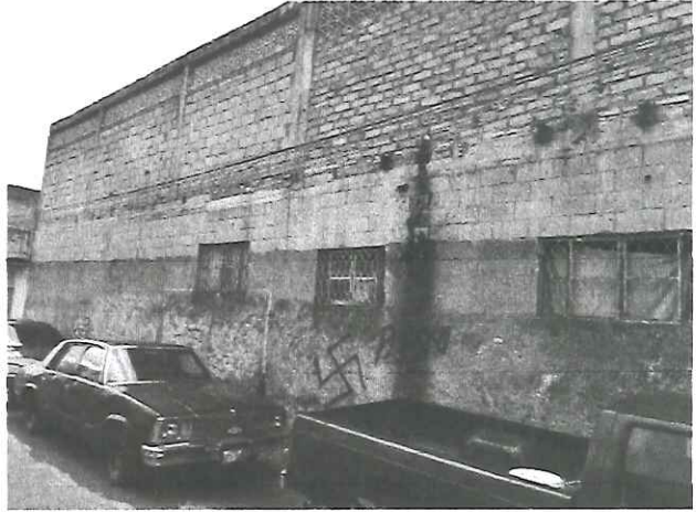
Vista facha posterior Edificio B
