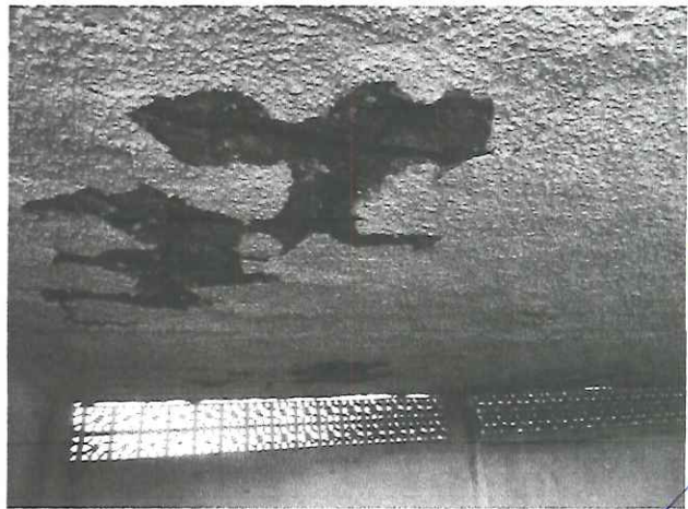
Losa de azotea en edificio B (entre ejes A-B de 4-7)
