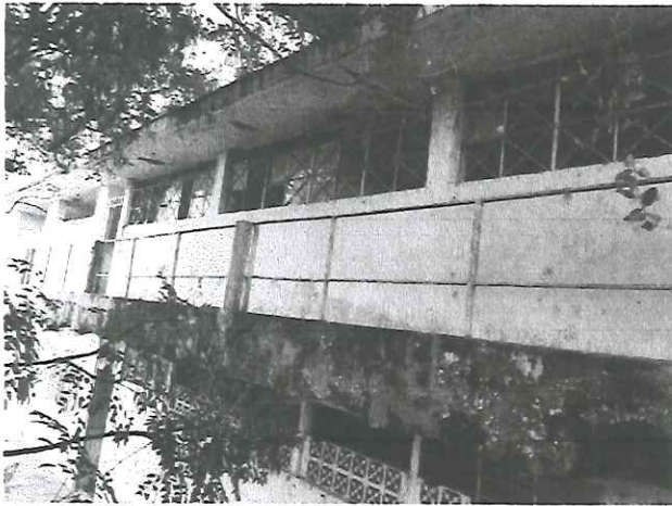
Vista de pasillo en planta alta Edificio B
