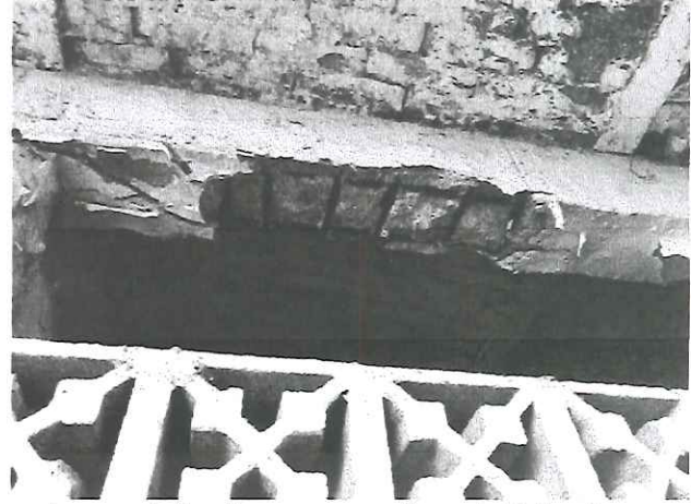
Imagen trabe de apoyo para losa de Entrepiso
