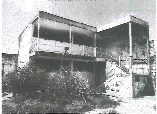
Vista de Edificio A
