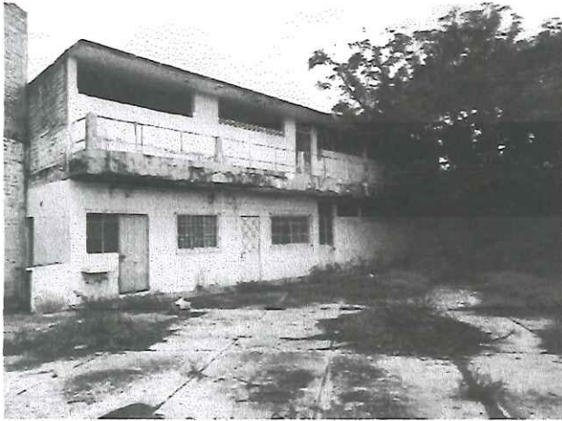
Vista fachada principal Edificio B
