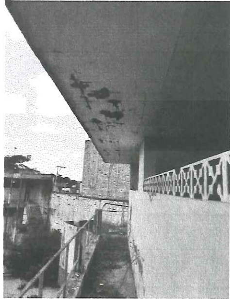
Marquesina losa azotea (entre ejes B-C de 1-4)
