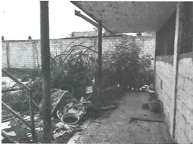
Marquesisa en planta baja y columnas C1
