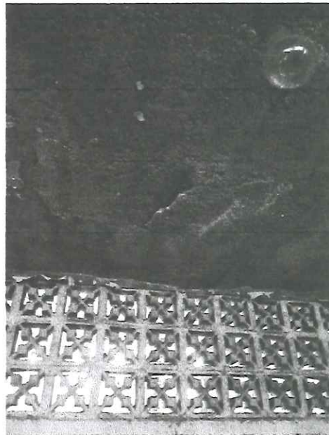
Imagen losa de entrepiso
